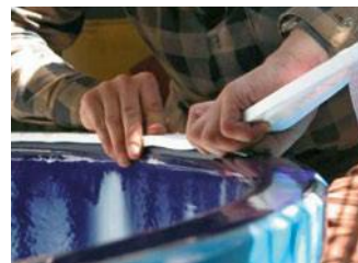
Montage von GORE® Dichtungsband Serie 1000
